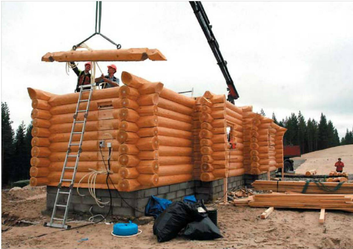
Tsasouna yksityiskohtiin kuuluvat monimutkaiset salvokset ja hirsiprofiilit. Melkein joka hirsi on erilainen ja seinä kaartuu ulospäin. Hirttä asentavat Meinrad Rohner (vas) ja Kimmo Neuvonen.
